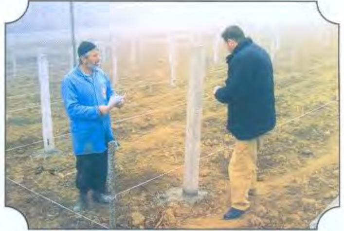
Bağda Beton direk tel çekimi/ VEZİRKÖPRÜ
